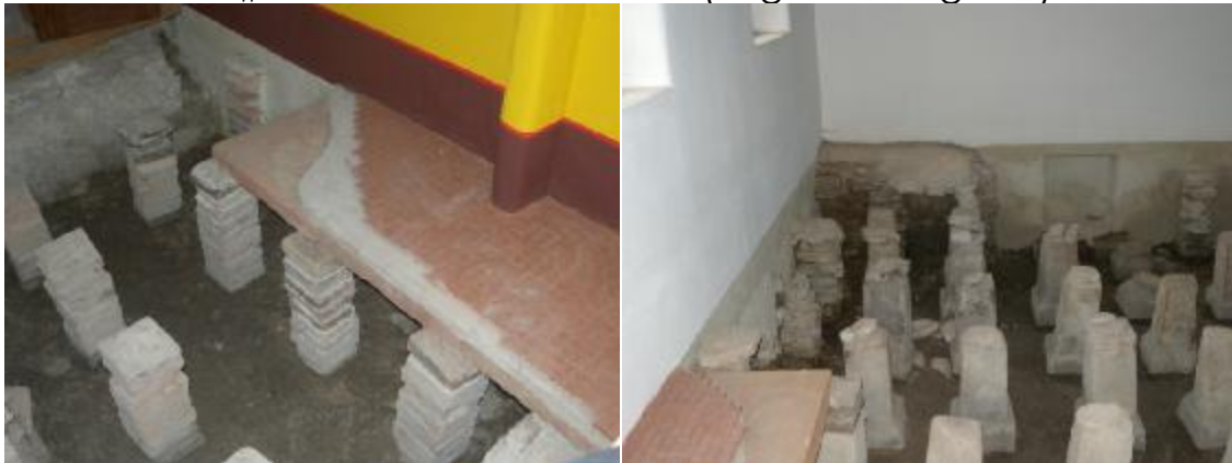
Die Heizung: links rekonstruiert, rechts das Original
